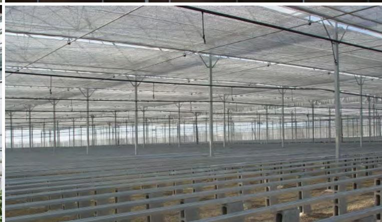
Os ecrãs são malhas têxteis que se colocam a modo de cobertura móvel na parte alta da estufa; o sistema de abertura e fecho permite-nos posicioná-las sem nenhuma adulteração do cultivo em função das condições climáticas, podendo, inclusivamente, criar um obscurecimento total no interior da estufa.
